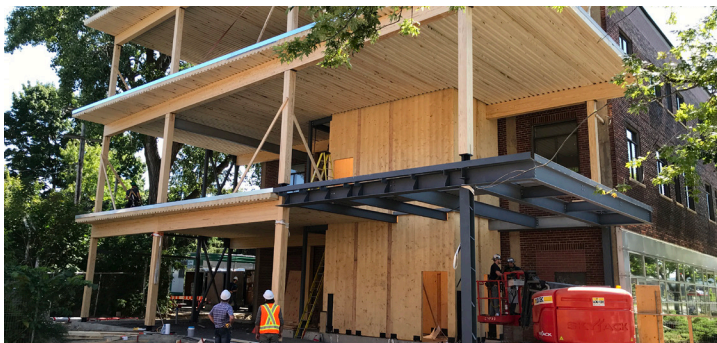
© Jodoin Lamarre Pratte architectes inc.
