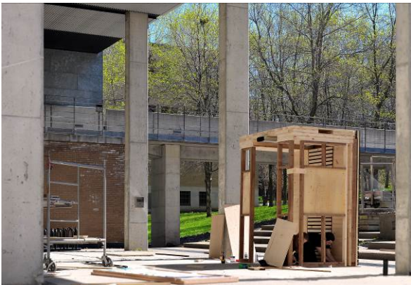
Construction d'un prototype à l'échelle 1:1
